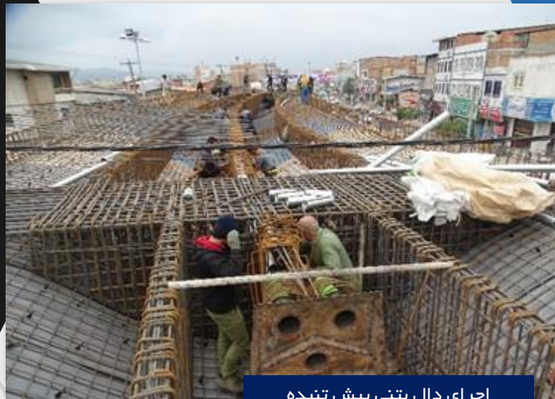
اجرای دال بتنی پیش تنیده
